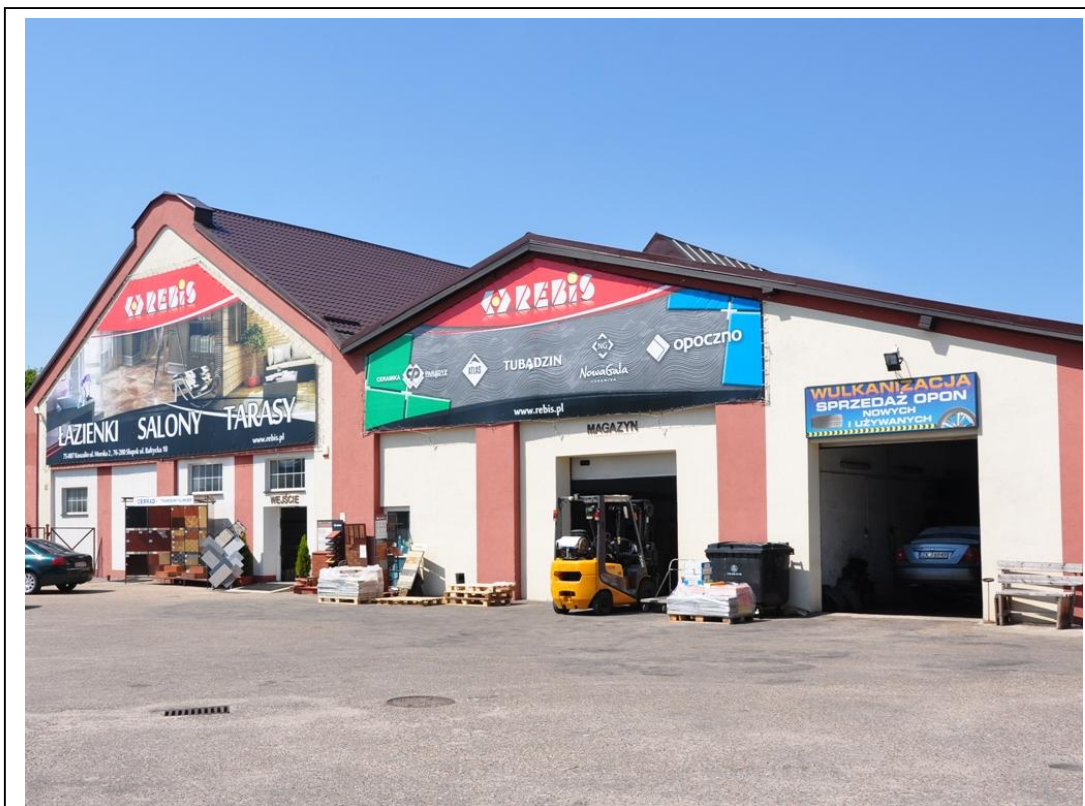
Zajezdnia tramwajowa, ob. magazyn - ul. Morska
