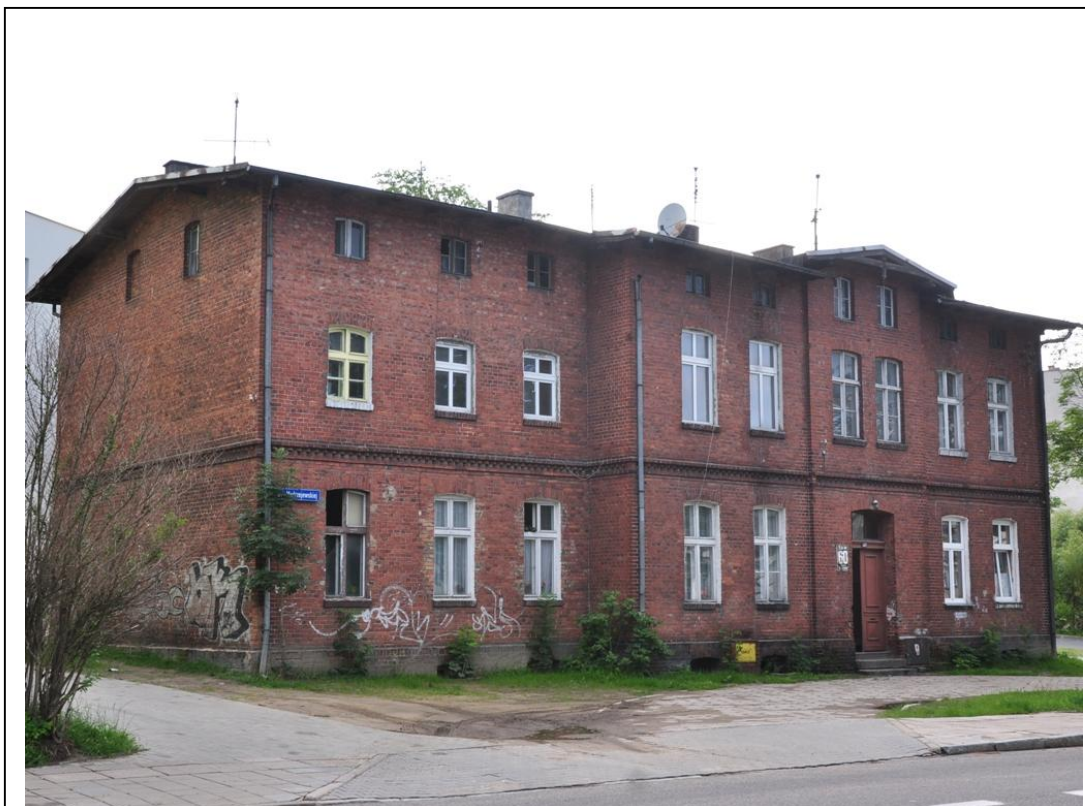
Dom wielorodzinny – ul. Modrzejewskiej
