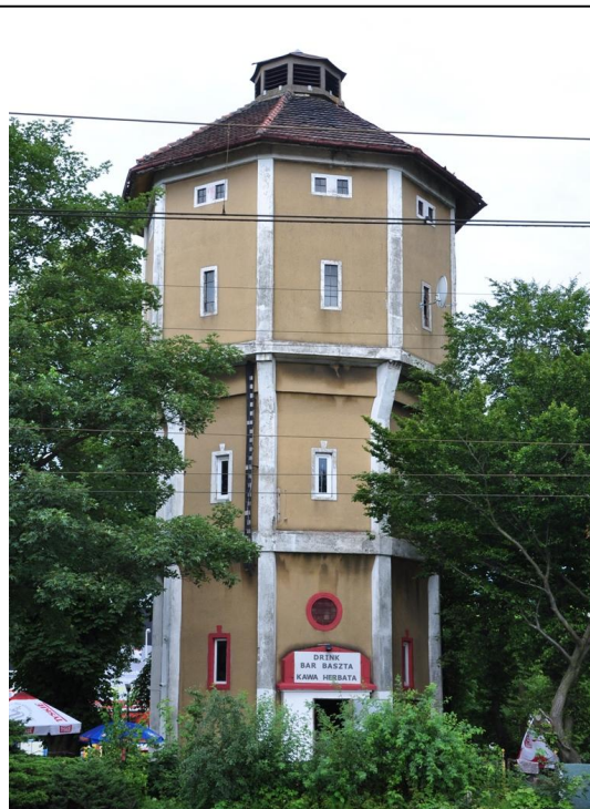
Kolejowa wieża ciśnien – ul. Armii Krajowej
