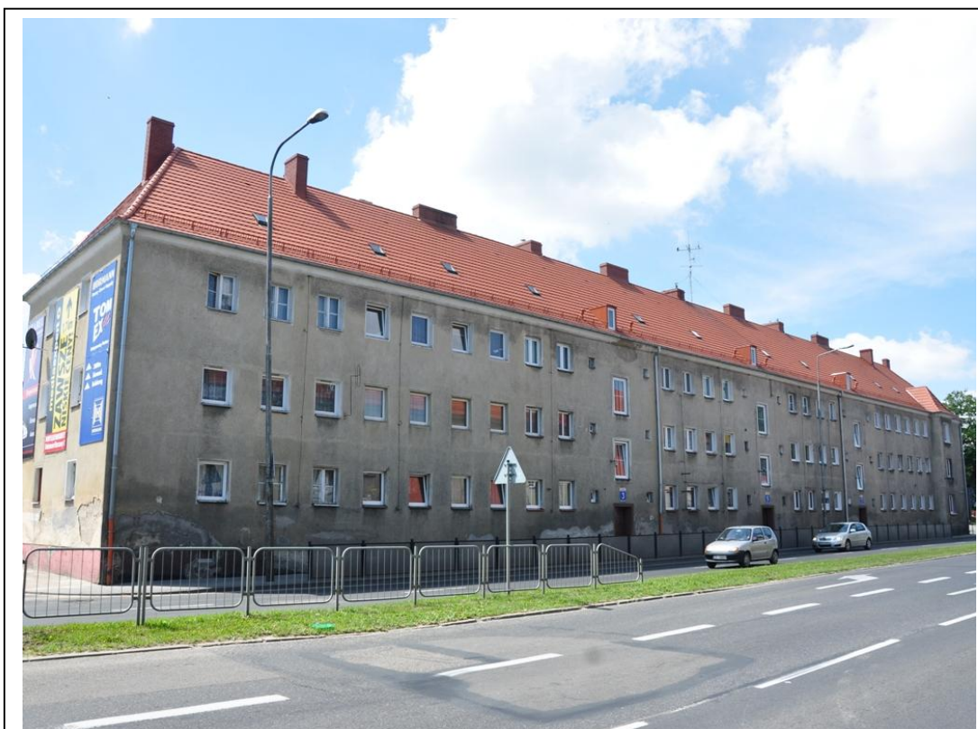
Blok wielorodzinny – ul. Krakusa i Wandy
