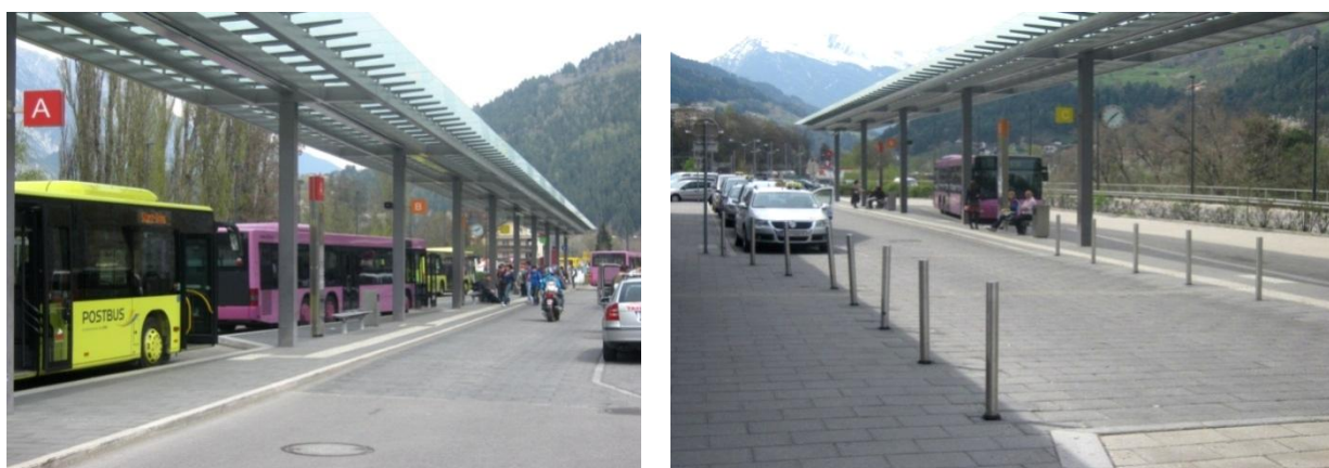
Rys. 12.2.2. Węzeł przesiadkowy przy stacji Landeck – Zams (Austria): przystanki autobusowe, postój taksówek oraz parking Kiss&Ride.
