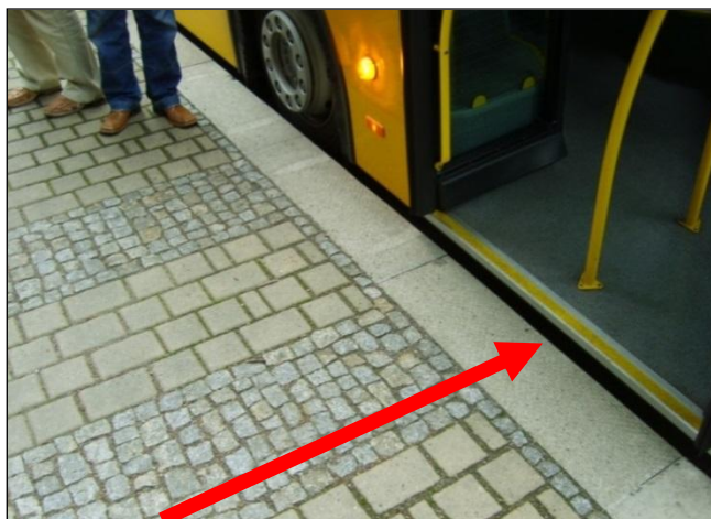
Rys. 9.8.2.2. Strefa wejściowa – inny rodzaj nawierzchni naprzeciwko pierwszych drzwi autobusu.
