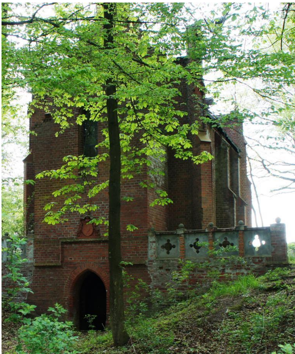
18. Łęgi – kaplica rodowa
