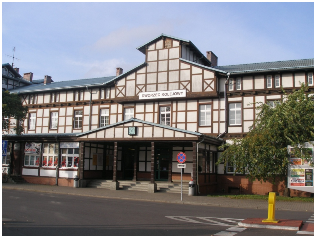
Rys. 10. Budynek dworca PKP w Białogardzie
