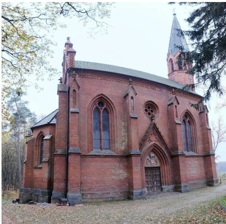
Wicewo – kościół (1869 r.) DWORY I PAŁACE
