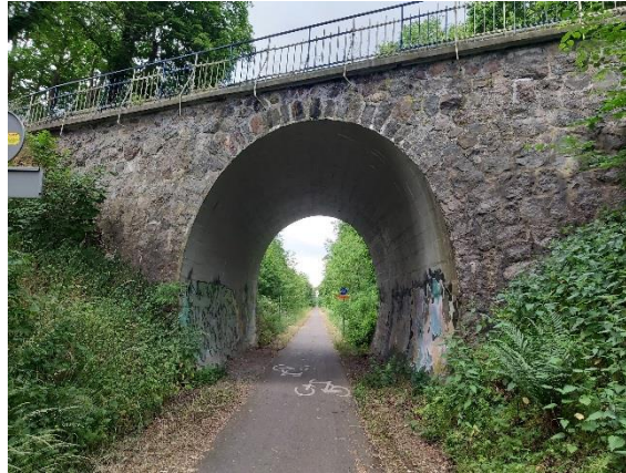
Ryc. 13. Wiadukt kolejowy niedaleko Wierzbna
