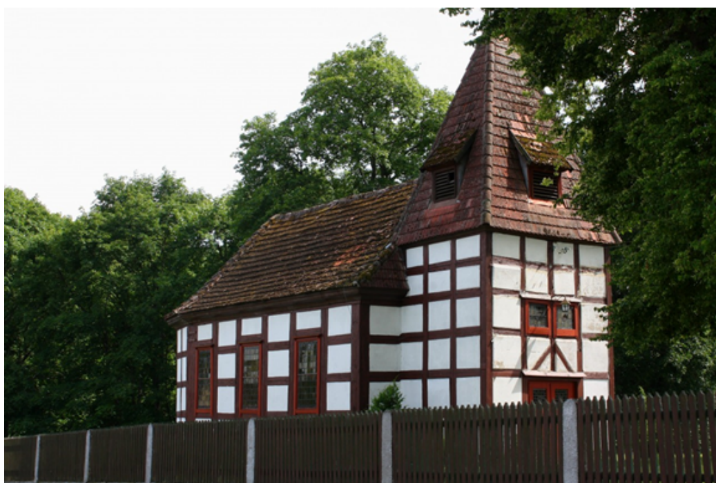
Rysunek 6. Kościół ewangelicki, ob. rzymskokatolicki filialny pw. Matki Boskiej Różańcowej w Drawieniu (przed i w trakcie remontu)
