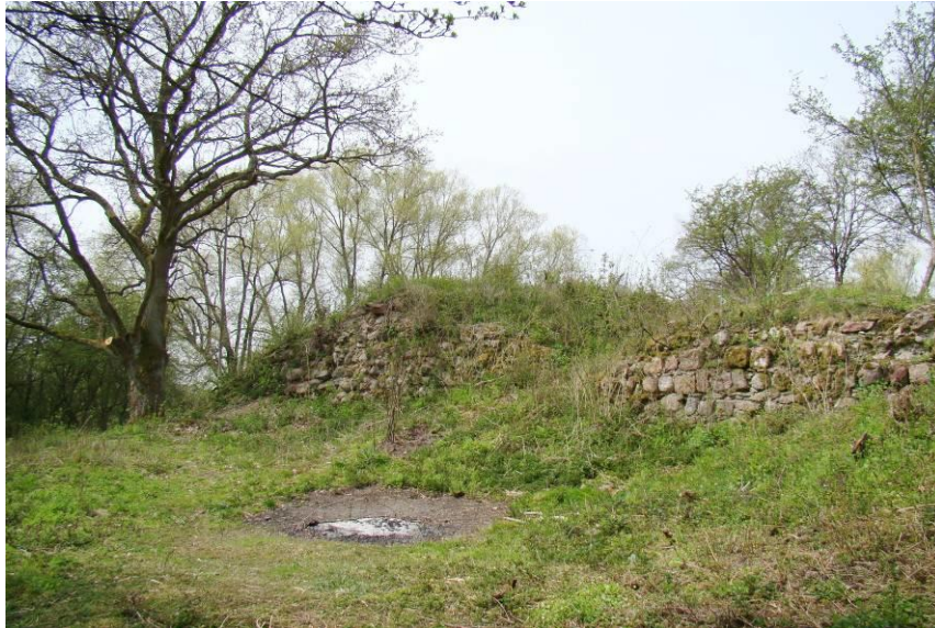
Szadzko, wzgórze zamkowe (fragm. ściany), fot. 2013
